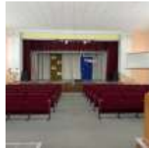
Ремонт ДК «Горняк» в п.Вишневогорск
